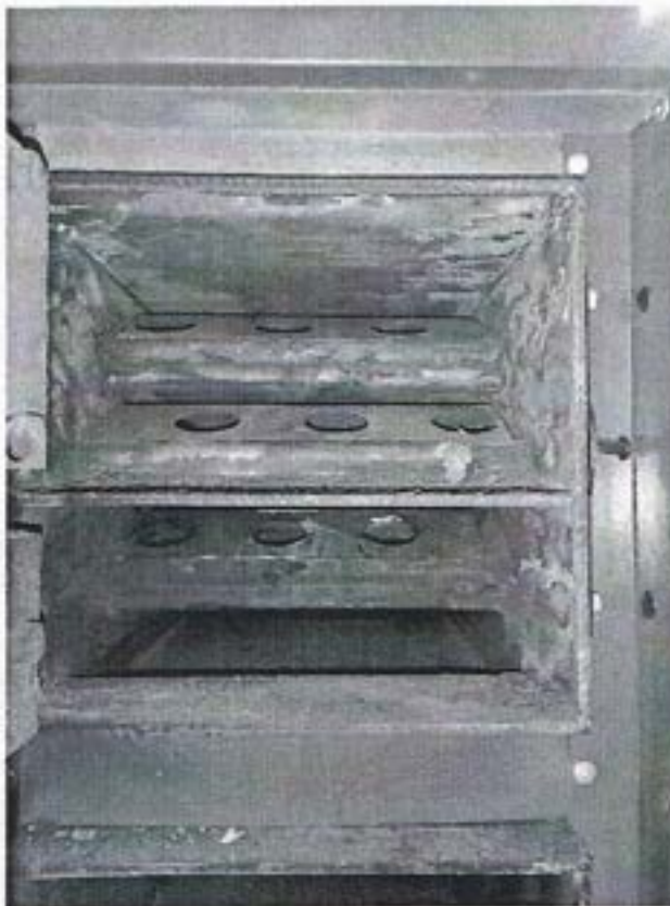
Rysunek 6 Górną komora wymiennika i zawirowywacze
