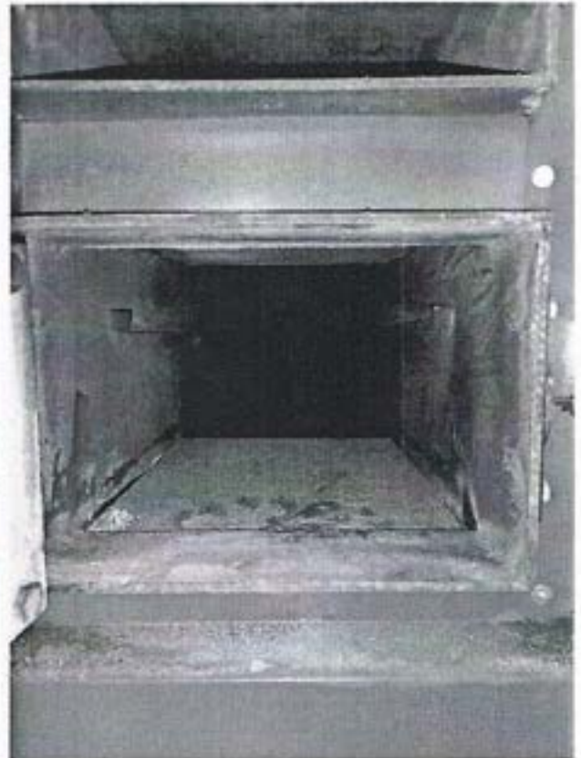
Rysunek 7 Komora spalania
