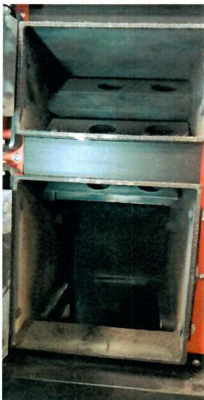
Rysunek 6 Górną komorę wymiennika i zawiórowacze
